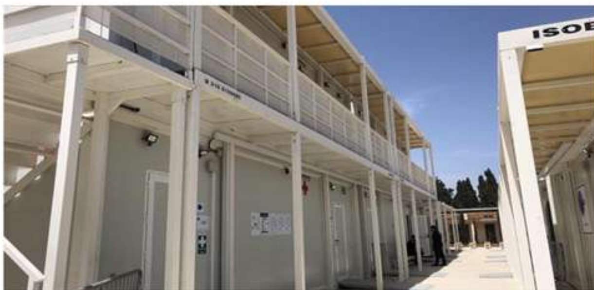
Koncem roku 2020 bylo ve snaze zvýšit kapacitu úřadu EASO provádět registrace a vést pohovory postaveno osm nových kancelářských buněk.
