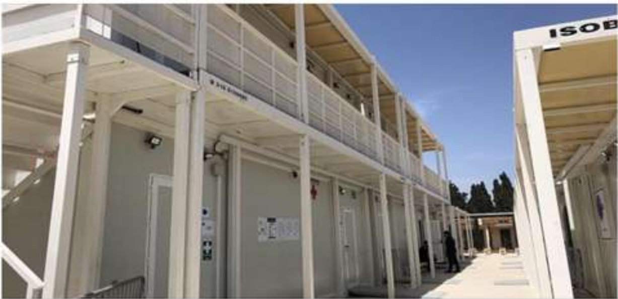
Vuoden 2020 loppupuolella pystytettiin kahdeksan uutta toimistokonttia, joiden avulla pyrittiin lisäämään EASON valmiuksia rekisteröintien ja puhuttelujen tekemiseen.
